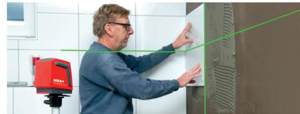
Una linea laser orizzontale e verticale chiaramente visibile forma una croce con angolo di 90° esatti.
